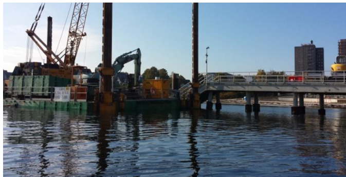
Abbildung. 8: Hafen-Baustelle in Kiel-Schilksee
